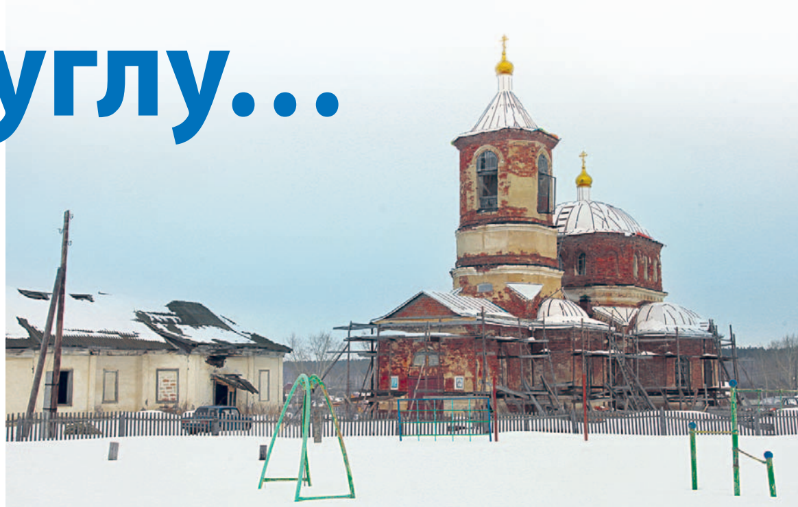
Свято-Троицкий храм – единственное здание в селе, которое стоит в строительных лесах.
